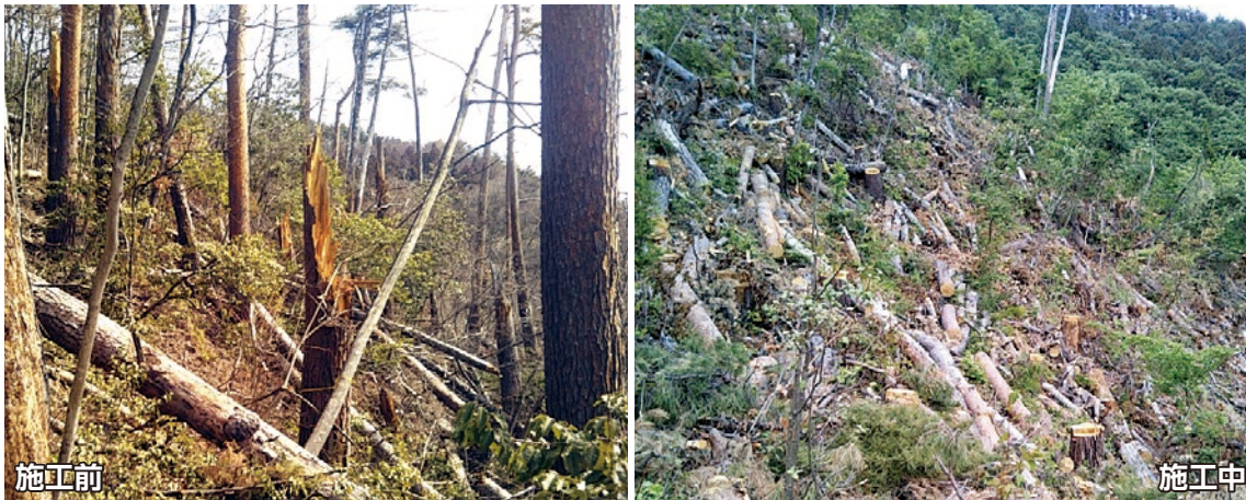
池田町の県発注の公共事業「保安林緊急改良事業第6号工事」を受注、現在施工中
